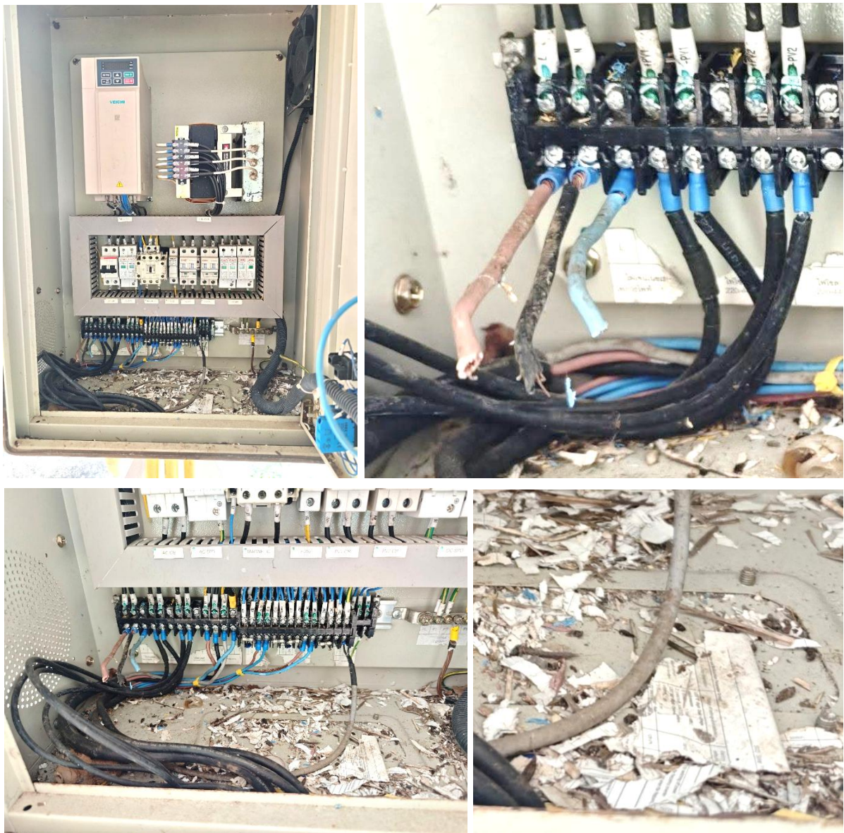
รูปที่ 27: ความเสียหายของสายไฟและอุปกรณ์ภายในตู้ควบคุมระบบปั้มน้ำพลังงานแสงอาทิตย์ (Solar Cell) ของวิสาหกิจชุมชนสวนเกษตร ส.บุญมีฤทธิ์ ที่ได้รับความเสียหายจากสัตว์กัดแทะ
