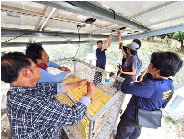
รูปที่ 37: ภาพบรรยากาศขณะทีมวิจัยตรวจสอบสภาพวงจรระบบแผงโซลาร์เซลล์ที่เสียหาย
