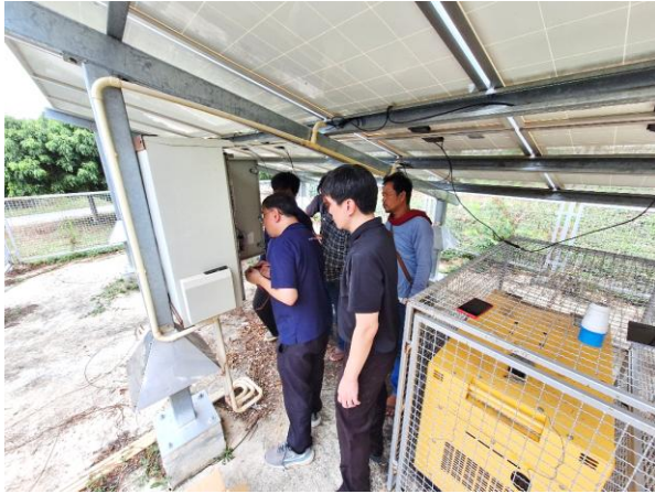
รูปที่ 36: ภาพบรรยากาศขณะทีมวิจัยใช้มัลติมิเตอร์วัดค่าแรงดันไฟฟ้า DC จากแผงโซลาร์เซลล์
