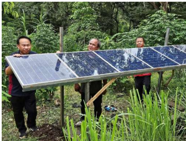
ภาพที่ 1.9 การติดตั้งแผงโซลาร์เซลล์เพื่อใช้เป็นแหล่งพลังงานไฟฟ้าในสวนของเกษตรกร
